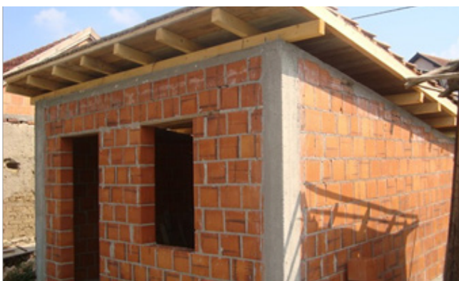
■ Projekat: „Renoviranje štale za ovce i koze“.
